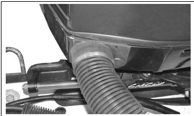
Flexible conduit installation
