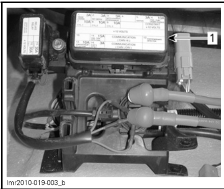
1. Caixa de fusíveis
