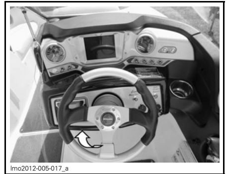
LOCALIZAÇÃO DO PAINEL DE DISJUNTORES
