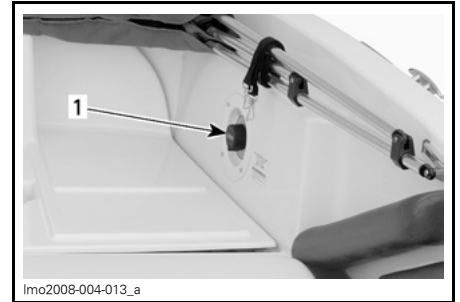
1. Interruttore batteria principale
