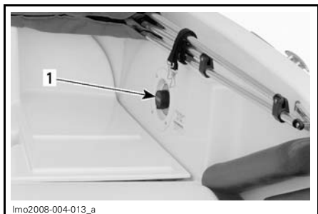
1. Interrupteur coupe-circuit principal de la batterie
