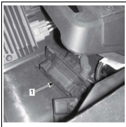
1. Caixa de fusíveis auxiliar
