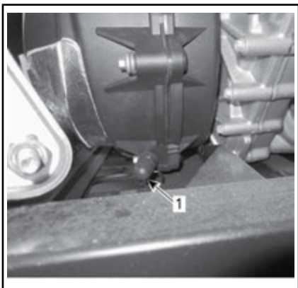
1. Drenaje de la CVT
