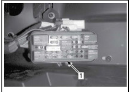
1. Caja de fusibles principal
