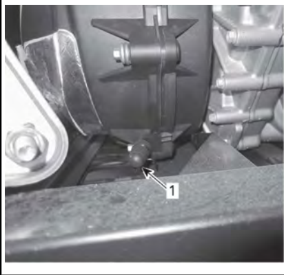
1. Drenaje de la CVT
