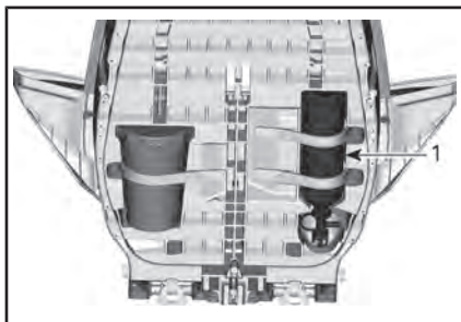
1. Extintor de incêndio
