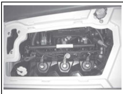
CAIXA DE VENTILAÇÃO REMOVIDA
