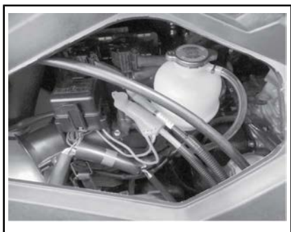
COMPARTIMENTO DO MOTOR - TAMPA DE ACESSO ESQUERDA REMOVIDA
