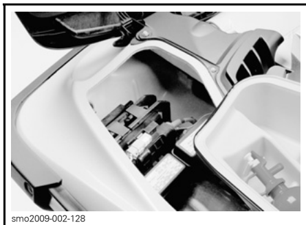
バッテリーとヒューズのアクセス - 右手のストレージビンを外した状態
