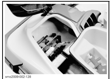
ACCESO A LA BATERÍA Y A LOS FUSIBLES - CONTENEDOR DE ALMACENAMIENTO DERECHO EXTRAÍDO
