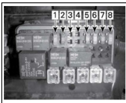
SÄKRINGAR - VÄNSTER SÄKRINGSBOX
