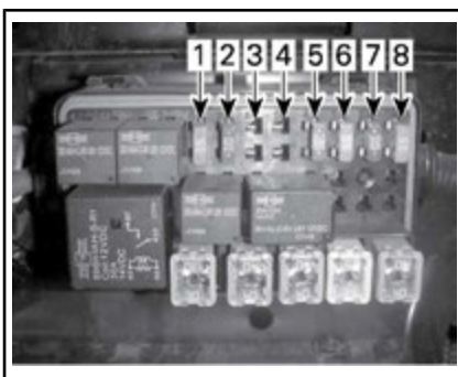
SIKRINGER – VENSTRE SIKRINGSBOKS
