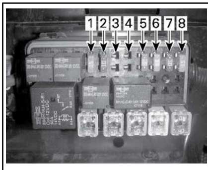
FUSÍVEIS - CAIXA DE FUSÍVEL ESQUERDA
