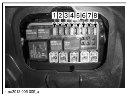
SÄKRINGAR - VÄNSTER SÄKRINGSBOX
