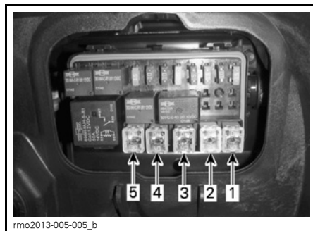
JCASE-SIKRINGER – VENSTRE SIKRINGSBOKS
