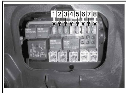
SICHERUNGEN – LINKER SICHERUNGSKASTEN
