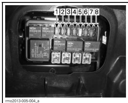
SIKRINGER – HØYRE SIKRINGSBOKS
