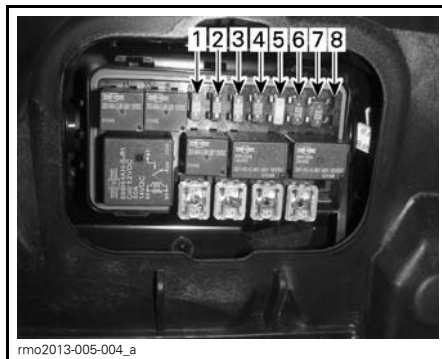
FUSIBLES - CAJA DE FUSIBLES DERECHA
