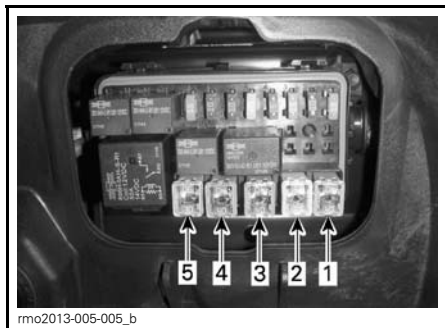
FUSIBLES JCASE - CAJA DE FUSIBLES IZQUIERDA
