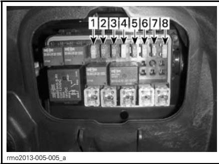
FUSIBLES - CAJA DE FUSIBLES IZQUIERDA
