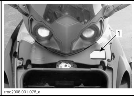
1. Sulakekotelo huoltokannen alla, etutavaratilan takana
