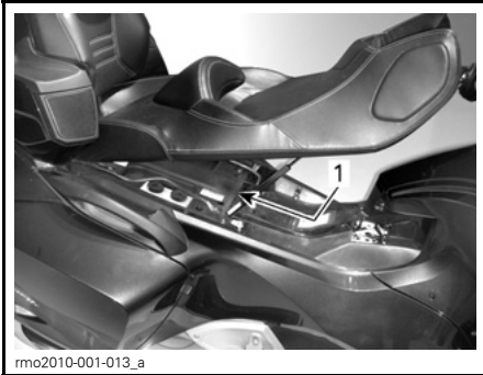
1. De zekeringenkast onder het zadel
