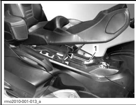
1. De zekeringenkast onder het zadel
