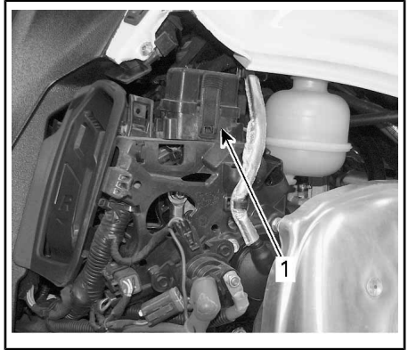
TYPBILD — HÖGER SIDA AV MOTORRUMMET
