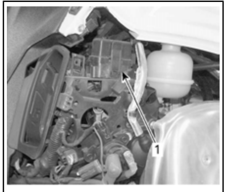
TYPBILD — HÖGER SIDA AV MOTORRUMMET
