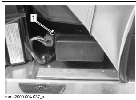
1. Boîte à fusibles
