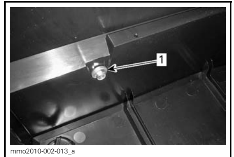
INTERNO DEL VANO BAGAGLI
