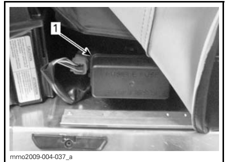
BOÎTE À FUSIBLES
