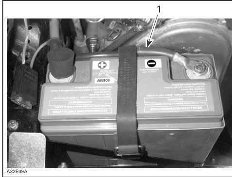
1. Negatiivinen kaapeli kiinnitysremmin alla
