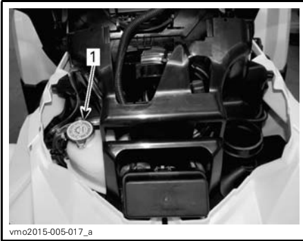
1. Réservoir de liquide de refroidissement
