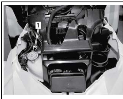
1. Réservoir de liquide de refroidissement
