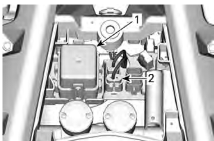
1. Sikringsboks foran 2. DPS-sikring
