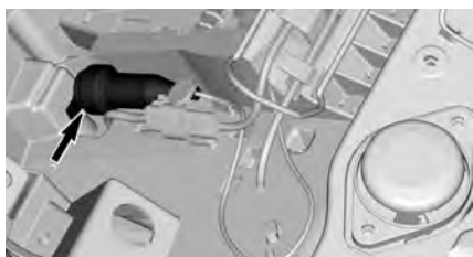
DC56 – BAKRE KABELFÖRBEREDELSE – UNDER PASSAGERARSÄTET
