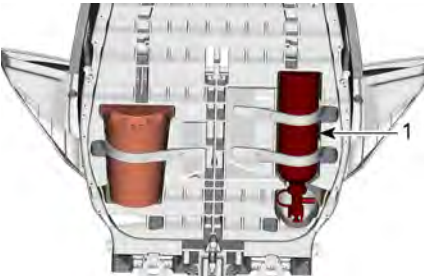
1. Extintor de incêndio
