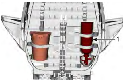
1. Extintor de incendios
