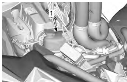
1. Réservoir du liquide de refroidissement
