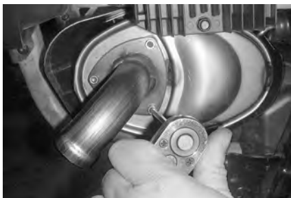
典型示例 - 拆卸尾管
