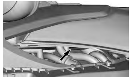
DC34 - CIRCUITO CENTRAL PARA ACCESORIOS DEL CLIENTE - TRAS EL PANEL DE ACCESO LATERAL IZQUIERDO
