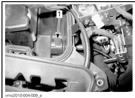
1. Filtre à air du compresseur ACS
