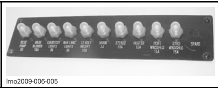
PANEL DE DISYUNTORES
