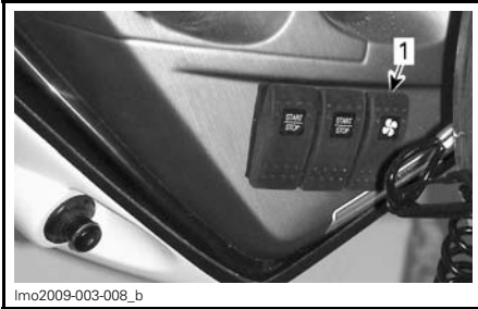
1. Bilge blower switch
