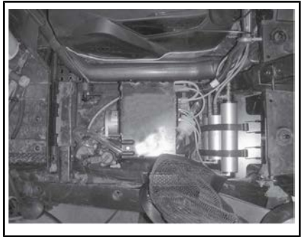
COMPRESSOR DA ACS
