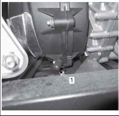
1. Drenaje de la CVT
