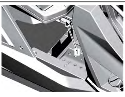
1. Caja de fusibles auxiliar
