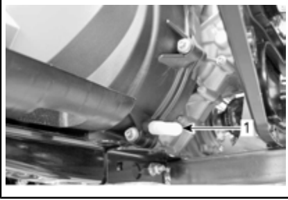
1. Drenaje de la CVT
