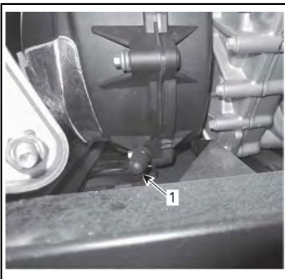
1. Drenaje de la CVT
