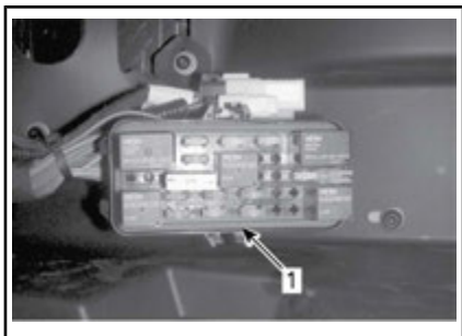
1. Caixa de fusíveis principal
