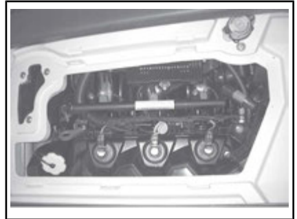
CASSA DI VENTILAZIONE RIMOSSA
